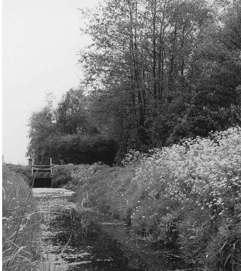
8.2. De stuw van de Leigraaf ter hoogte van Schattenkerks bos. Dit is het punt waar het water gescheiden wordt. Op deze afbeelding is het beemaalde gedeelte zichtbaar. Aan de niet zichtbare zijde van de stuw gaat de stroom links in oostelijke richting, de zogenaamde vrije loop.
